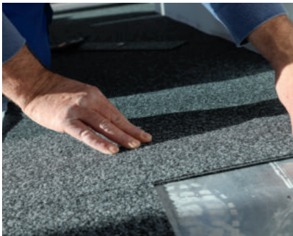
Kraftschlüssige Verlegung
